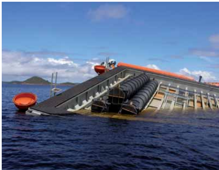
La gigantesca guarnizione di Oldrati è stata montata a puzzle direttamente sul posto con pezzi realizzati da stampo
