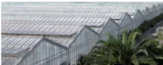
Le lastre multistrato in PC sono le più adatte per la copertura di serre e vivai
